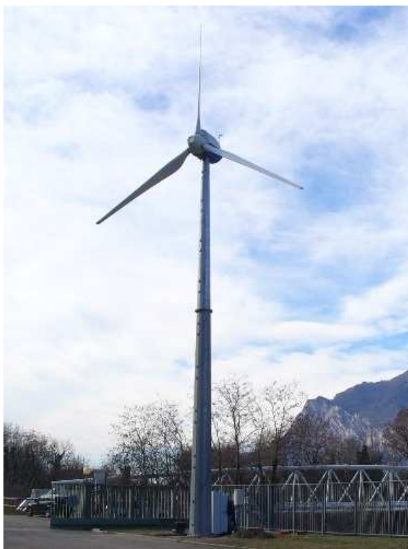
Figura 1 – Aerogeneratore Tozzi Nord mod.TN535.
